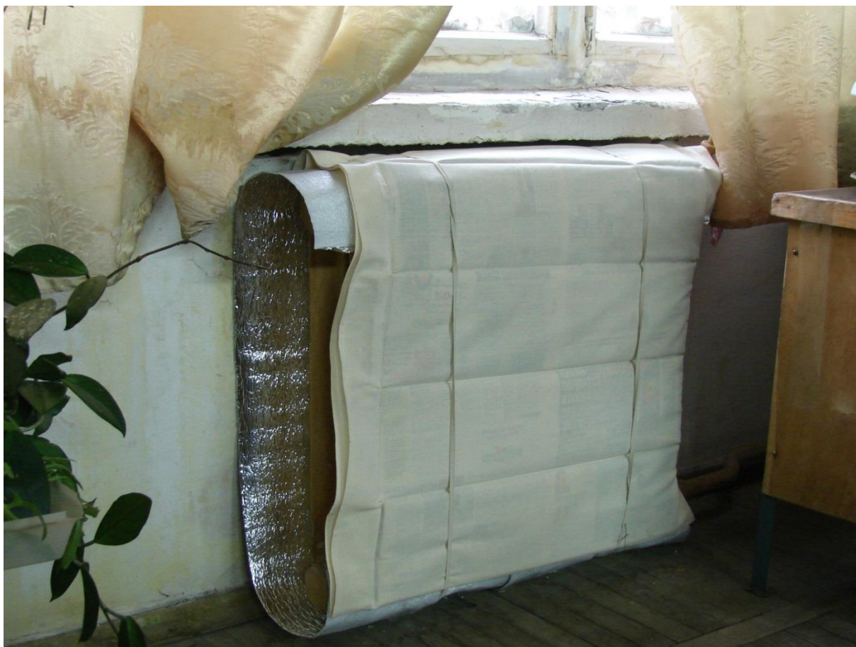
Рис. 3.5. Захисний екран на батареї опалення на кафедрі ергономіки і проектування одягу (ауд. 2-0501)
