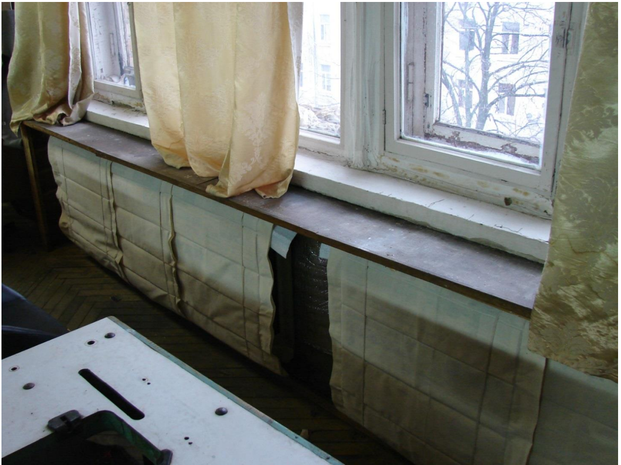
Рис. 3.6. Захисний екран на батареях опалення на кафедрі ергономіки і проектування одягу (ауд. 2-0501)
